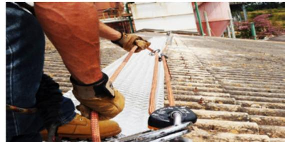
Figura 10 - Procedimentos para o Telhadista andar sobre o Telhado
