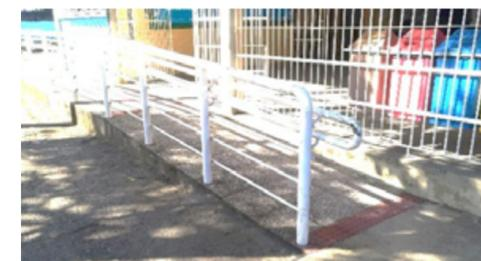
Figura 8 - Rampa com Guarda-corpo e Corrimão
