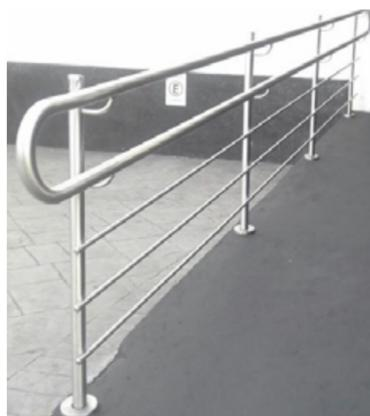
Figura 25 - Guarda-corpo em aço inox (montantes e corrimão duplo)
