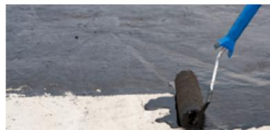
Figura 14 - Manta Asfáltica
