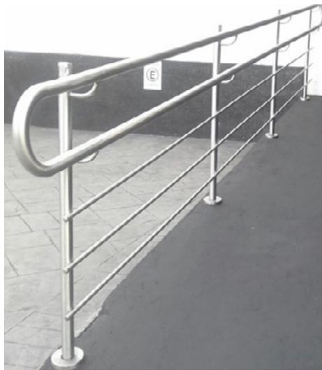
Figura 25 - Guarda-corpo em aço inox (montantes e corrimão duplo)
