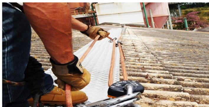
Figura 10 - Procedimentos para o Telhadista andar sobre o Telhado
