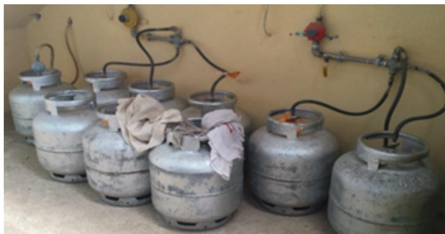
Figura 7 - Instalação imprópria da Rede de Gás
