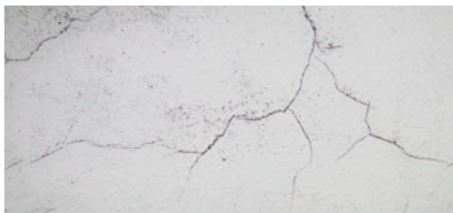
Figura 19 - Trincas em Muros
