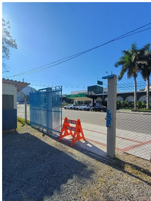
Foto 10 – Portão de entrada
