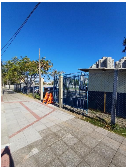
Foto 09 – Portão de entrada
