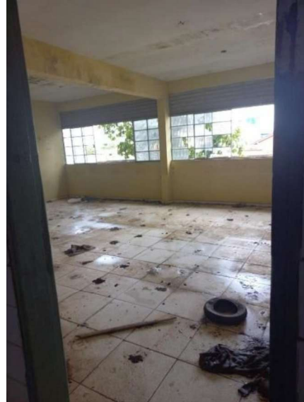
FOTO 28 – Sala de aula
