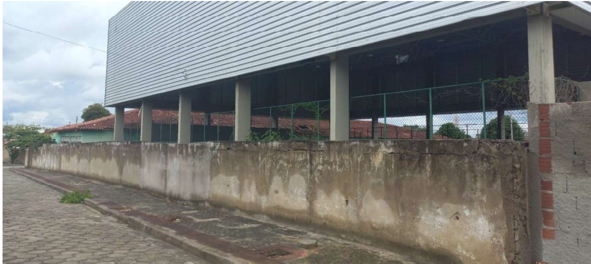
FOTO 03 – Fachada voltada para a Rua Ilhéus
