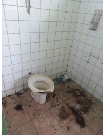
FOTO 32 – Banheiros ao lado da Cozinha
