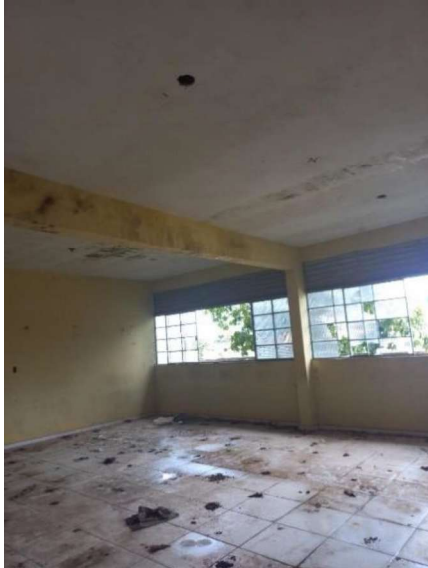
FOTO 27 – Sala de aula
