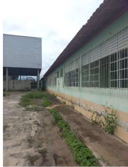
FOTO 10 – Paredes externas da Escola
