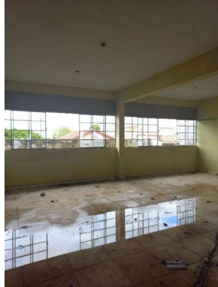
FOTO 22 – Sala de Aula
