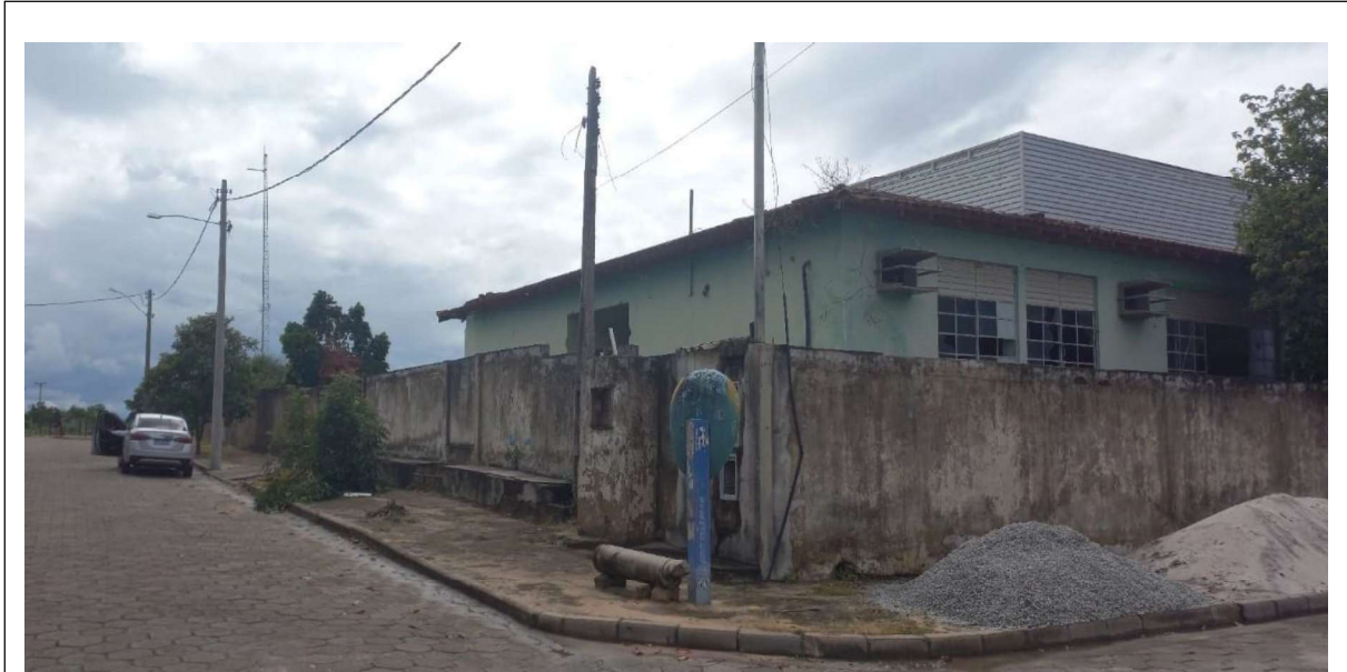
FOTO 01 – Fachada voltada para a Rua Itabuna
