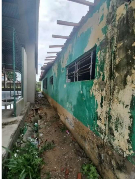
FOTO 11 – Paredes externas da Escola
