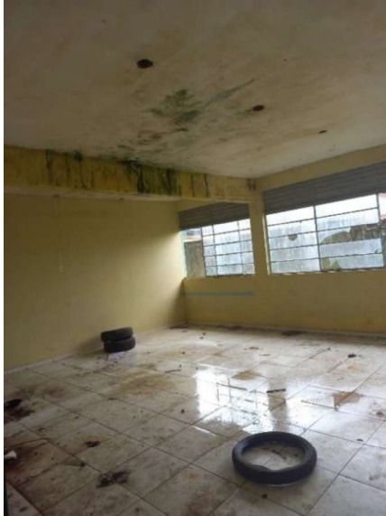
FOTO 21 – Sala de Aula
