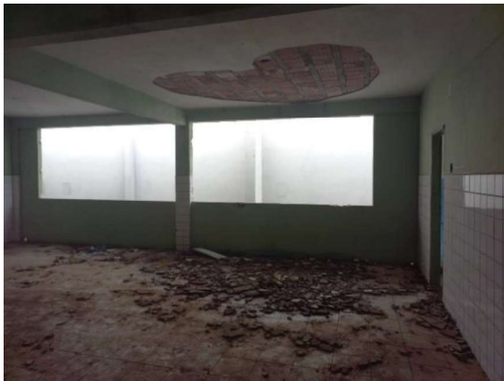
FOTO 15 – Teto da Circulação
