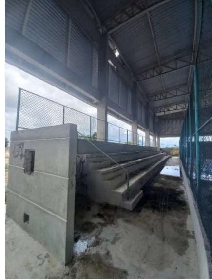
FOTO 46 - Arquibancada - Quadra Poliesportiva
