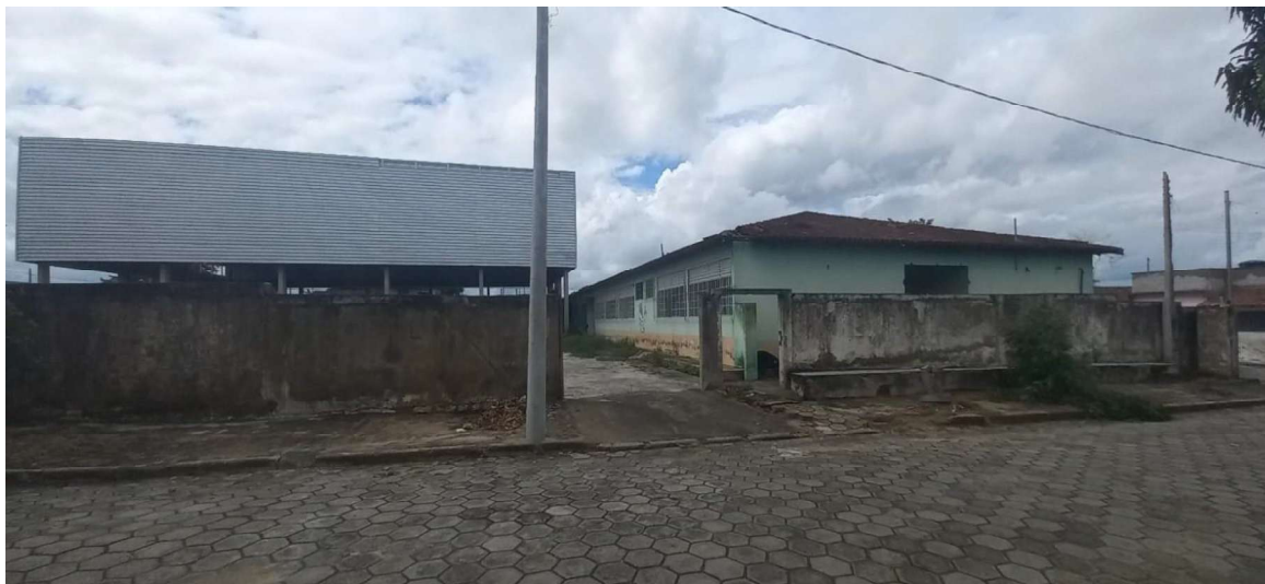
FOTO 04 – Acesso ao imóvel na Rua Itabuna
