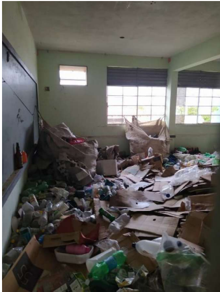
FOTO 41 - Acúmulo de Lixo na Sala
