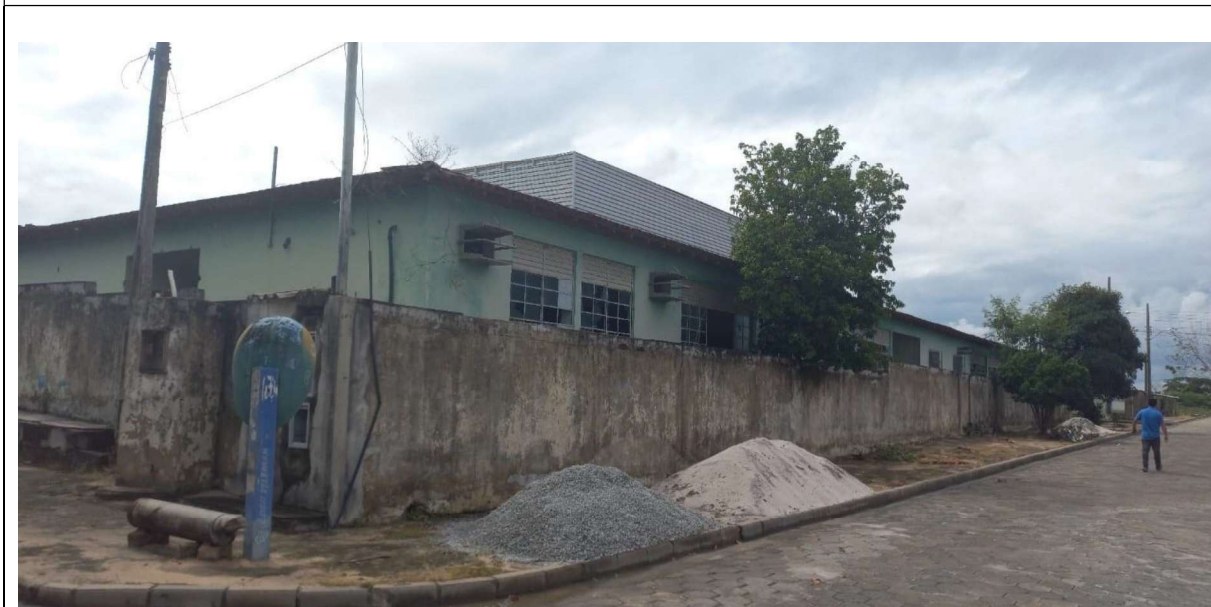
FOTO 02 – Fachada voltada para a Rua João Lopes
