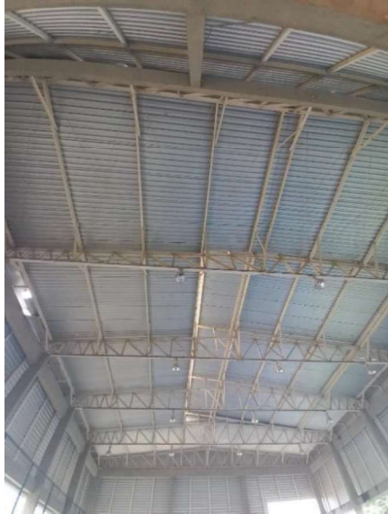
FOTO 47 – Estrutura metálica treliçada
