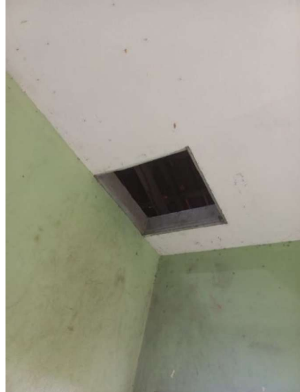
FOTO 40 – Portinhola de acesso ao telhado
