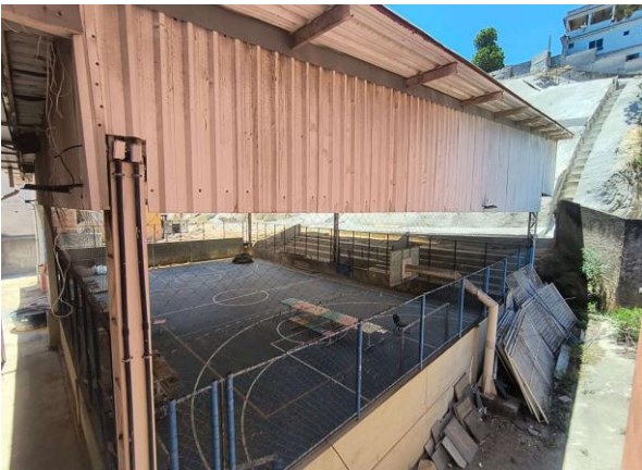
FOTO 48 - Quadra com vista parcial da contenção de maciço
