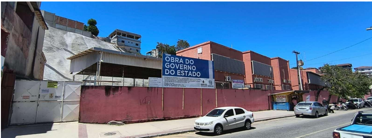
FOTO 02 - Vista Frontal da Escola com a Rua Ana Siqueira - Acesso de serviço
