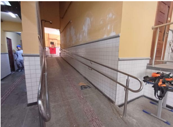
FOTO 24 - Rampa de acesso ao auditório
