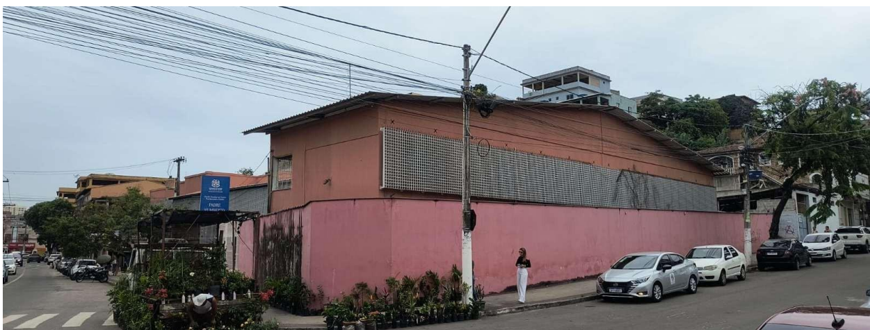
FOTO 03 - Cruzamento entre as Ruas Augusto dos Anjos e Ana Siqueira
