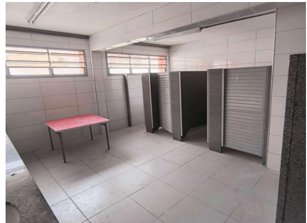
FOTO 19 - Banheiros Pav. Térreo
