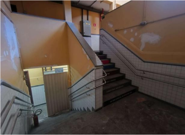
FOTO 28 - Escadas de acesso ao Pav. Superior
