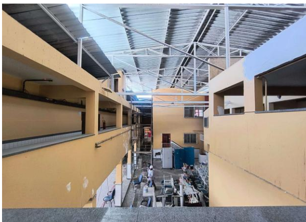
FOTO 12 - Cobertura do Pátio Coberto
