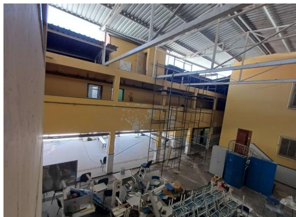
FOTO 13 - Vista parcial do Pátio Coberto
