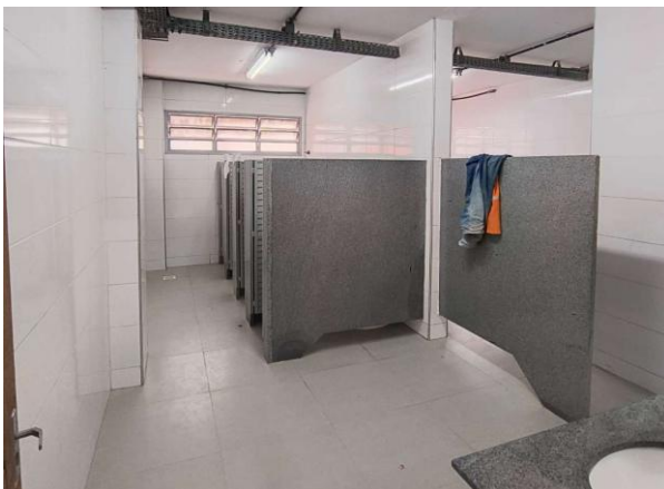
FOTO 20 - Banheiros Pav. Térreo
