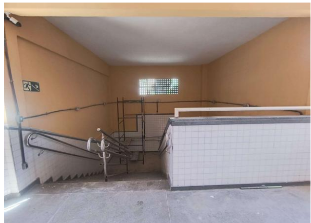
FOTO 27 - Escadas de acesso ao Pav. Superior
