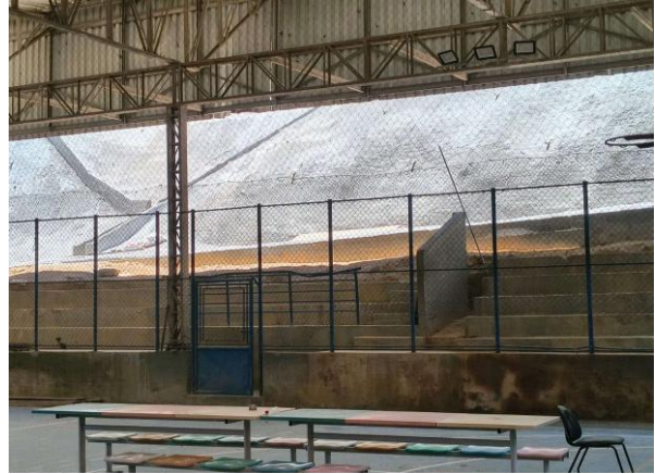
FOTO 47 - Vista parcial da contenção de maciço
