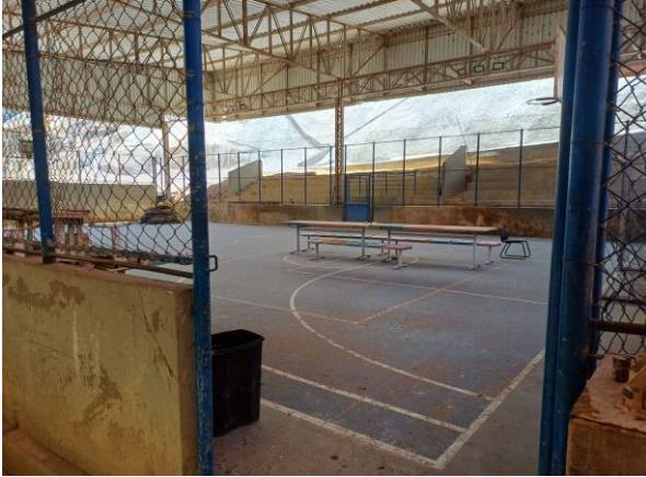
FOTO 46 - Quadra com vista parcial da contenção de maciço
