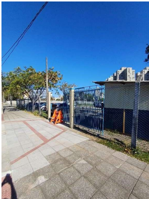
Foto 09 – Portão de entrada
