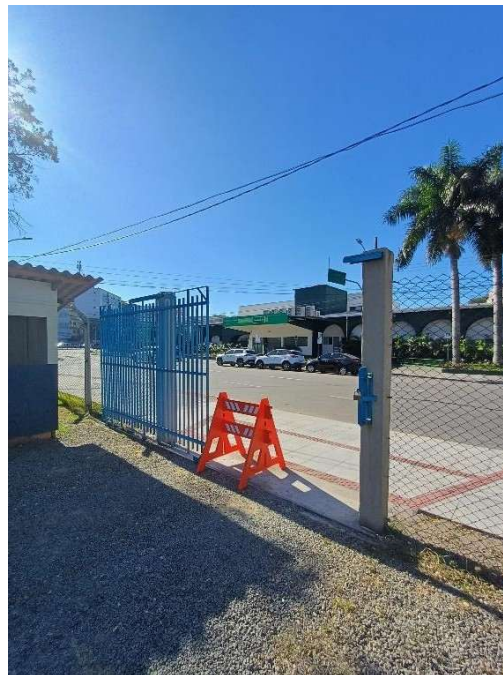
Foto 10 – Portão de entrada
